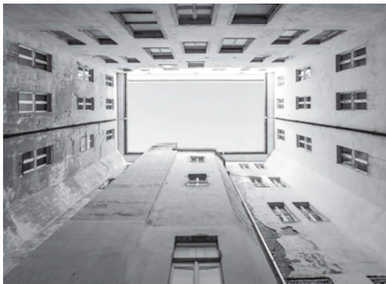
Bild 28: Blick vom Lichtthof des »Heidehofes« in den Himmel. Der Hof wurde als Freigang genutzt, 2016.
